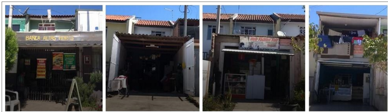
FIGURA 7: SITUAÇÃO ATUAL - FACHADAS MODIFICADAS TIPO (II) E TIPO (IV)
