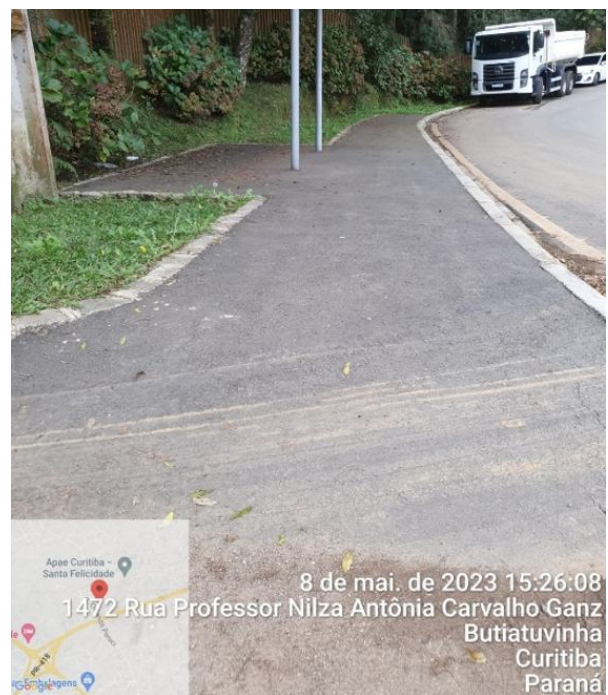
Figura 5 - Calçada em material fresado executada pela SMOP-Utip
