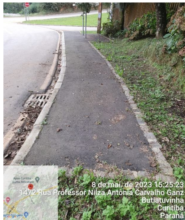
Figura 3 - Calçada em material fresado executada pela SMOP-Utip
