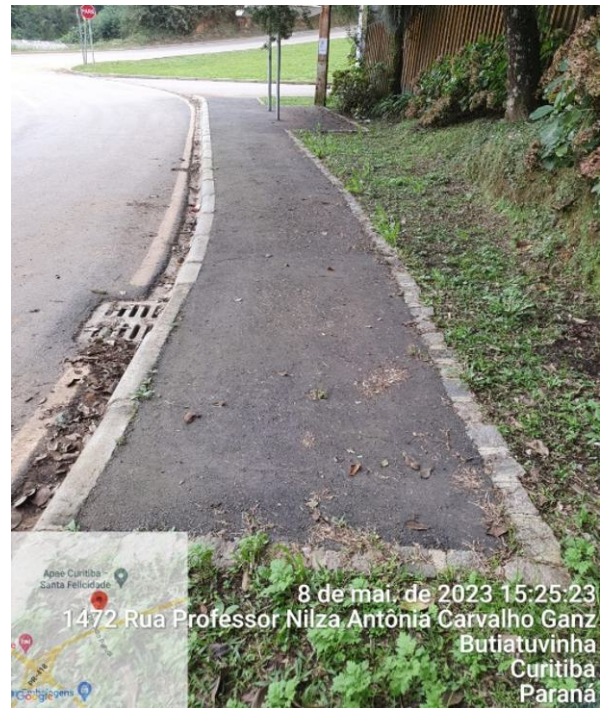
Figura 3 - Calçada em material fresado executada pela SMOP-Utip
