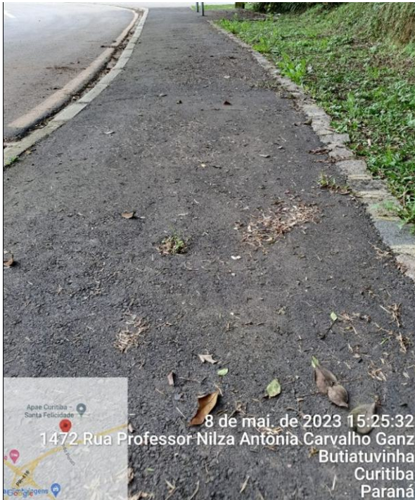
Figura 2 - Calçada em material fresado executada pela SMOP-Utip
