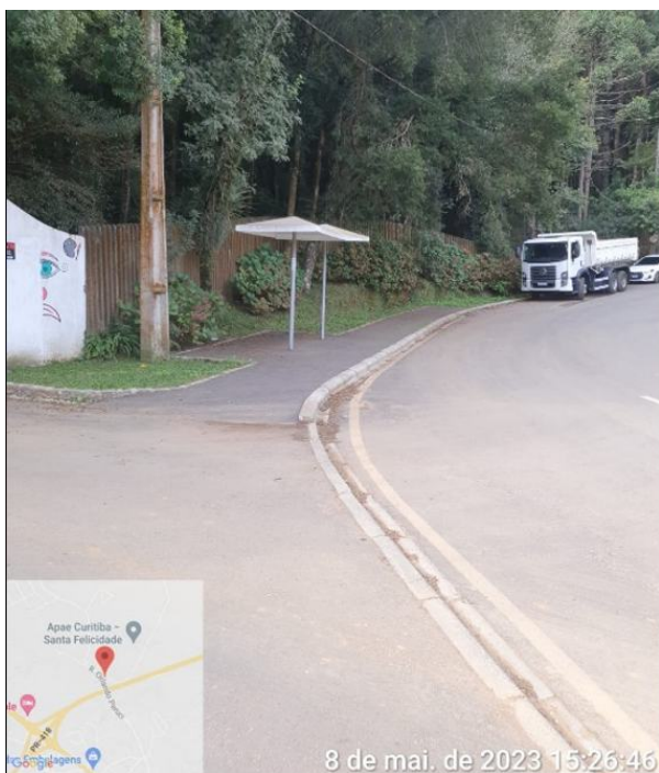
Figura 4 - Calçada em material fresado executada pela SMOP-Utip
