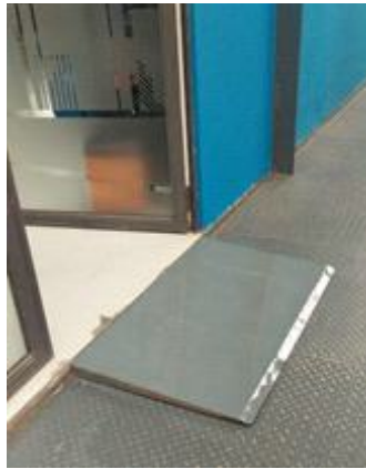
Figura 3: Rampa móvel para acesso à sala de ginástica na Regional Boqueirão
